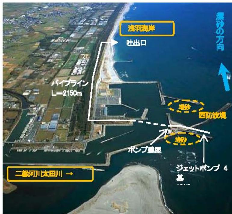
図 3-9-7-1 福田漁港・浅羽海岸サンドバイパス工法
