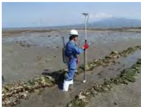
図 16 地形調査 (RTKGPS) 作業状況
