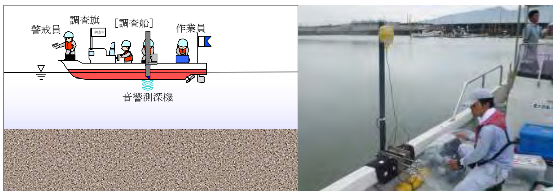
図 17 地形調査 (音響探測機) 作業状況
