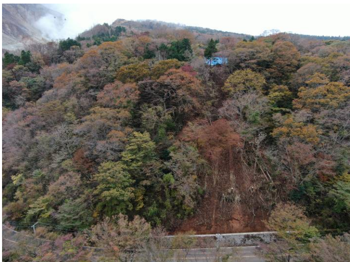
写真 3-6 被害箇所の全景
