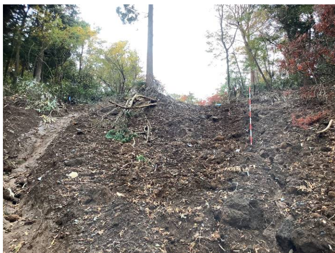
写真 3-7 崩壊地内の斜面の状況
