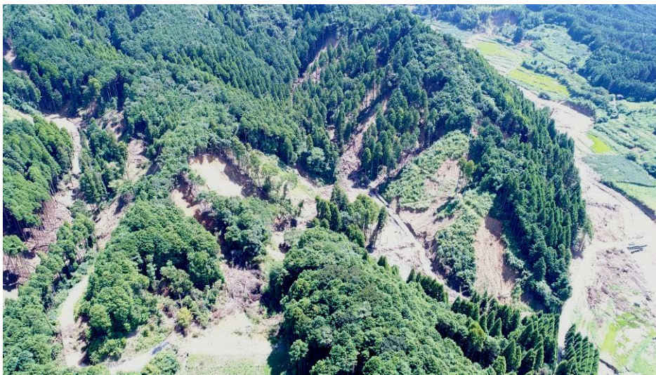
写真 3-14 ドローンによる被災直後の写真 2
