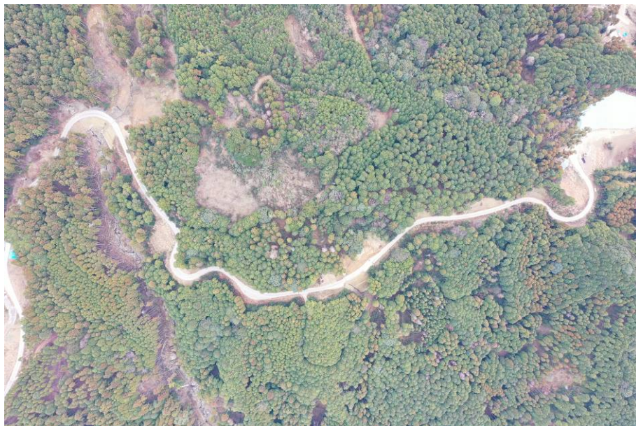
写真 3-16 復旧後の状況 1
