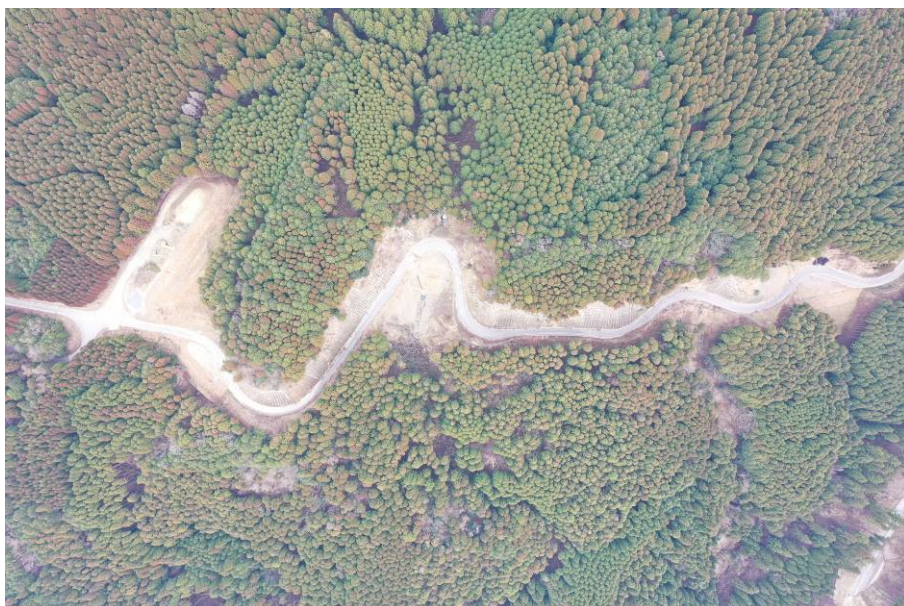
写真 3-17 復旧後の状況 2
