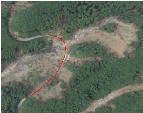
写真 3-12 被災延長の計測例
