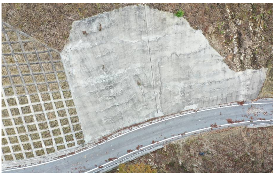
写真 3-18 復旧後の状況 3
