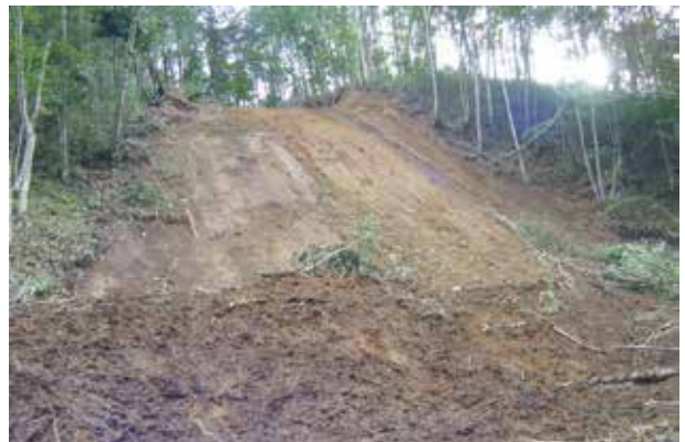
溪流沿いの崩壊状況
