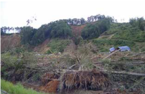
浅い谷と山腹の崩壊状況
