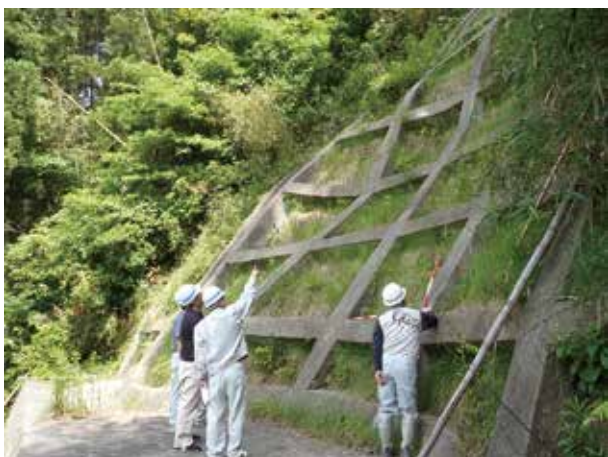
施設点検（徳島県三好市）
