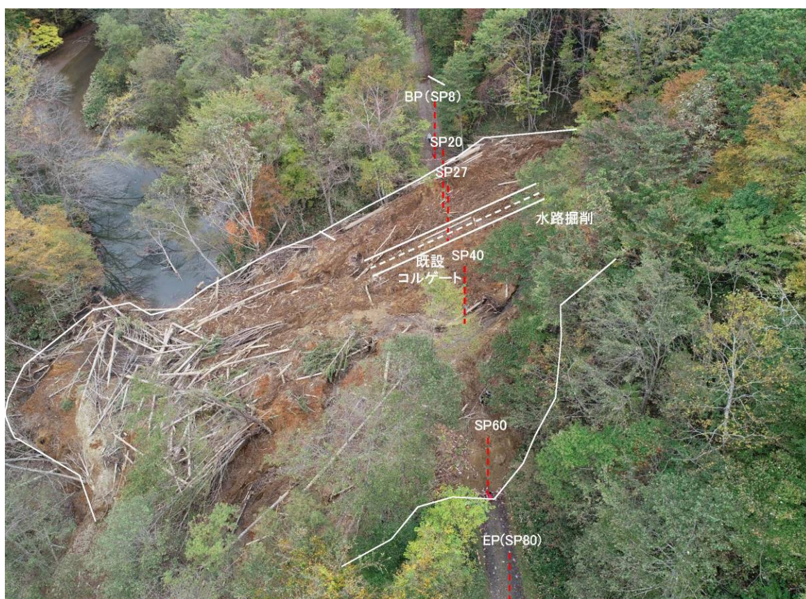
写真 2-8 平成 30 年災害 北海道 溪流部における土砂流出
