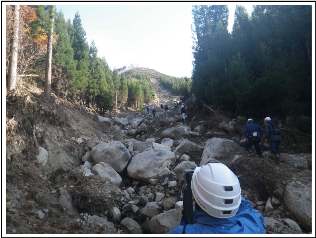
写真 2-7 宮城県丸森町廻倉地区
