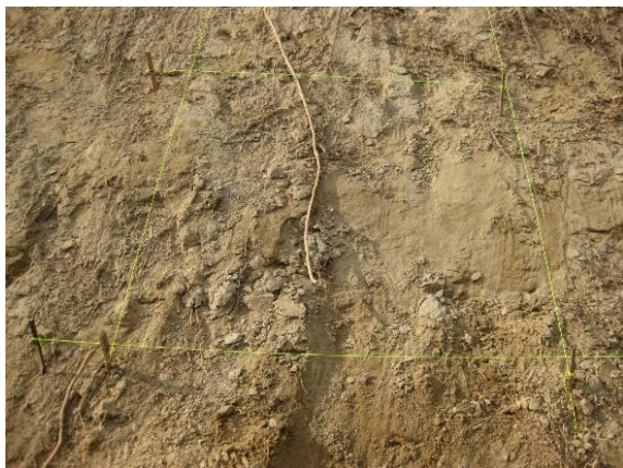
写真 2.2 崩壊面の調査ブロック
