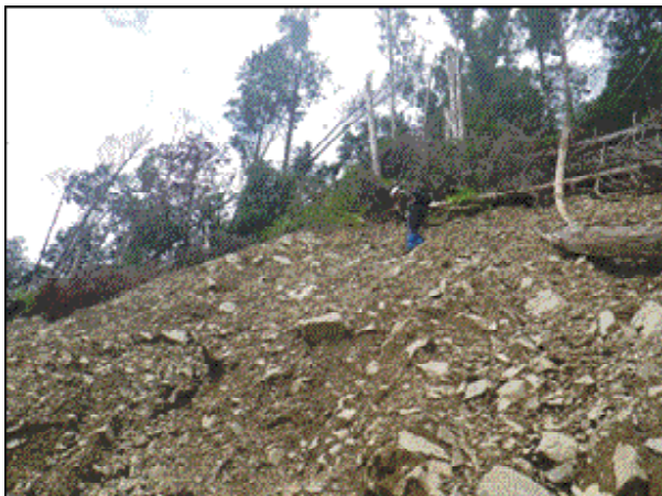
崩壊地上部の状況
