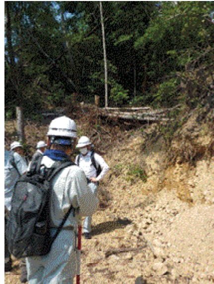
作業道の集水箇所
