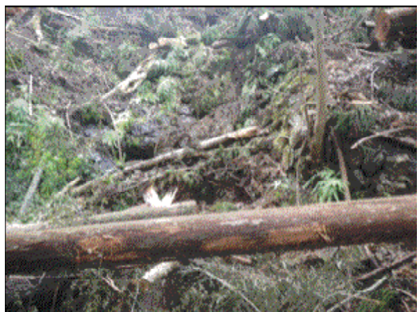
崩壊地下部斜面に見られる湧水
