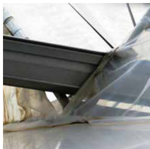
隙間がないか確認
