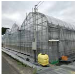
側窓・出入り口
