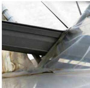
隙間がないか確認
