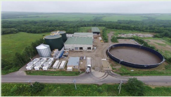
メタン発酵バイオマス発電
