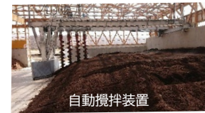
自動攪拌装置
