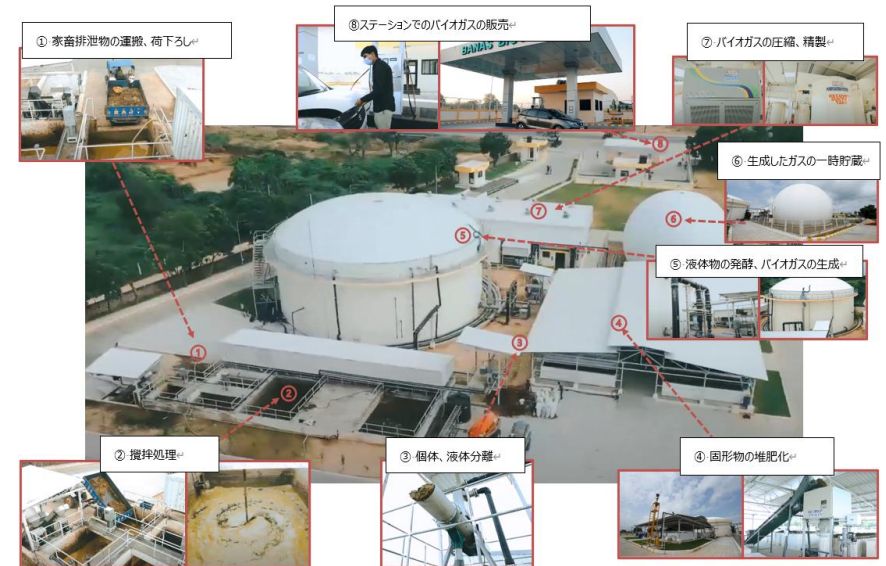
図. Banas-Daily バイオガスプラントの例
