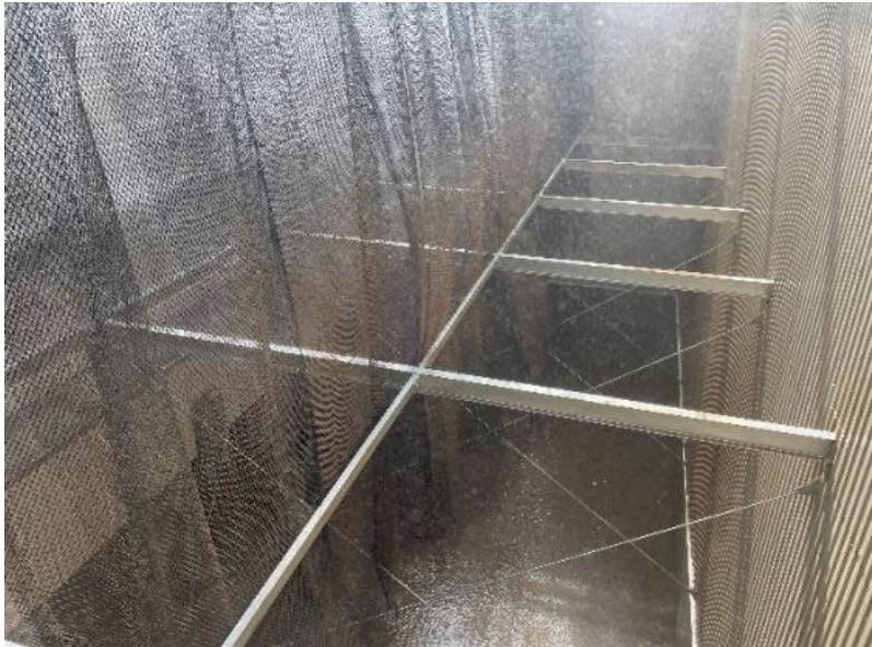
脱臭槽上部からの様子
