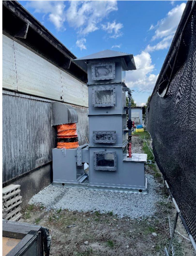
スクラバー方式による脱臭システム
