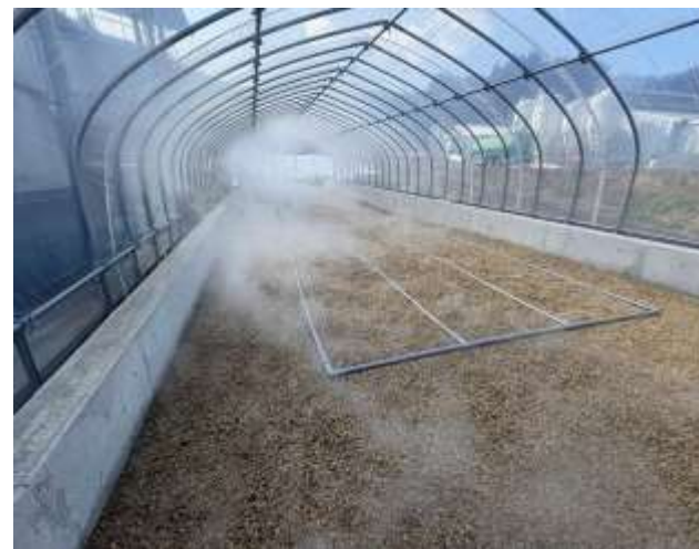
軽石脱臭槽内部(芳香消臭剤散布)
