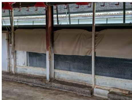
シート施工箇所
