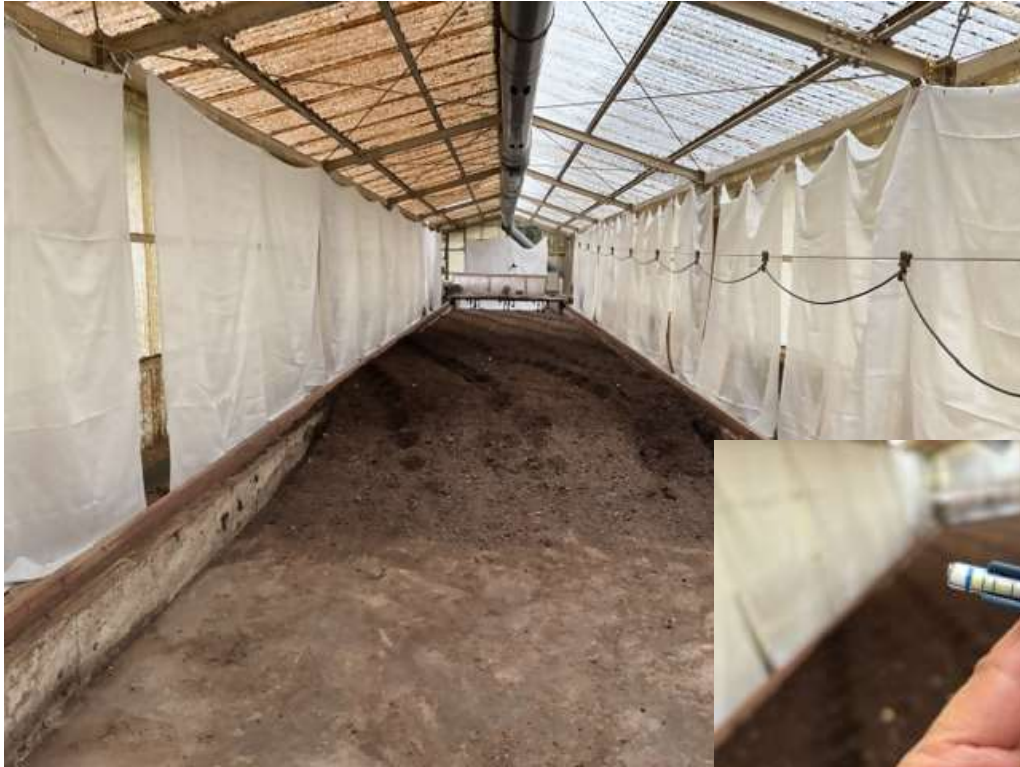
鶏ふん処理施設内にシートを施工 （高濃度アンモニア常時発生）
