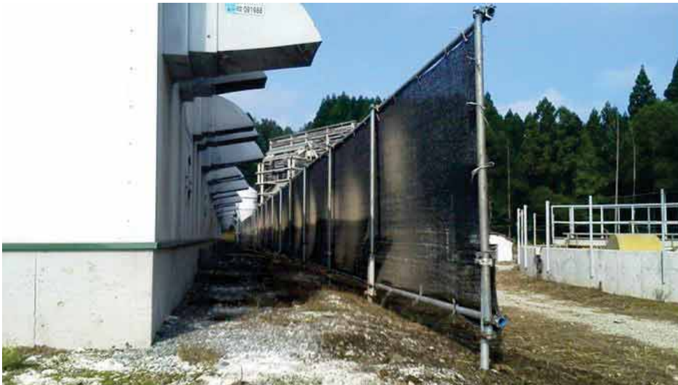
排気口への遮へい壁の設置
