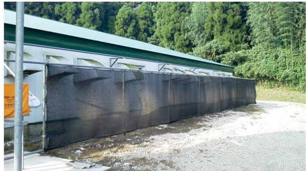
排気口への遮へい壁の設置
