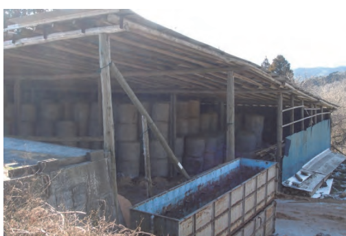
飼料・敷料保管庫
