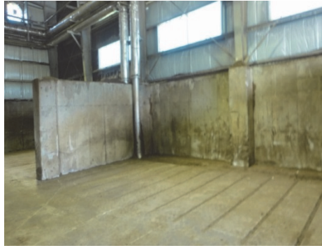
写真4 写真3を下面から乾燥するためのスペース
