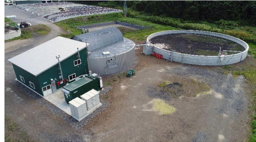
写真上 中央の円柱状の構築物が発酵槽。
