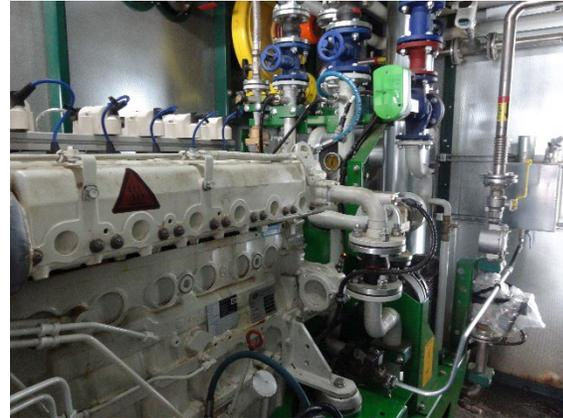
ガスエンジンと排熱回収部。排気量8,000cc
