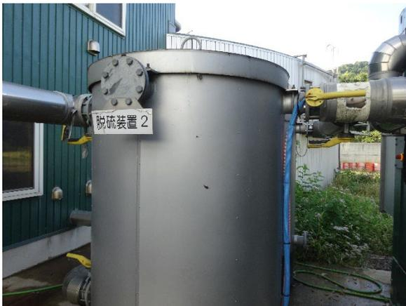
中身は酸化鉄でガスを通して脱硫している。
