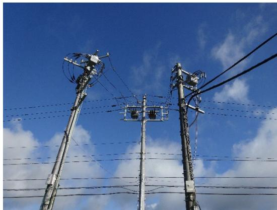
北海道電力の送電線への接合部。左電柱が売電側。右は買電。
