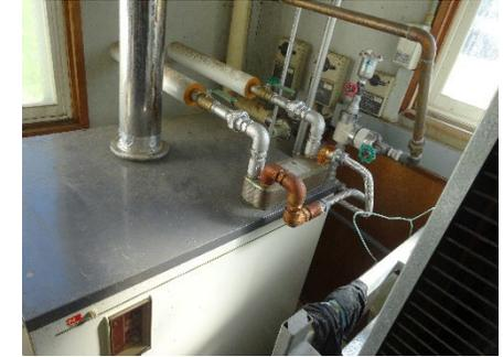
灯油ボイラー上部に設置された熱交換器
