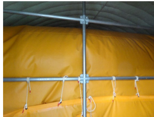
ガスホルダー。(ガスバッグ) 200 m 3 。
