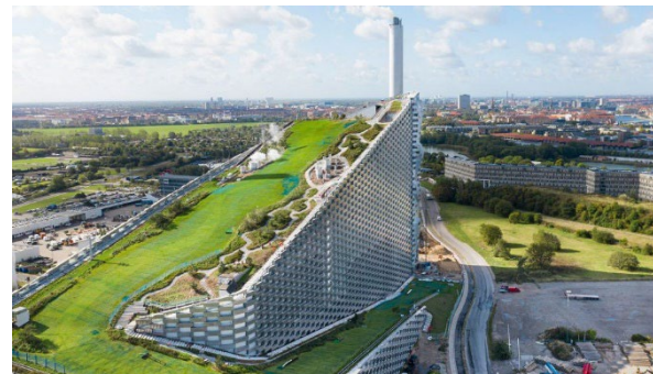
コペンハーゲンの廃棄物発電、地域熱供給システム コペンヒル。屋根では1年中スキーができる。 滞在中のシャワーは全てこうした熱由来によるもの。
