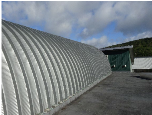
発酵槽の上に設置のガスホルダー格納庫
