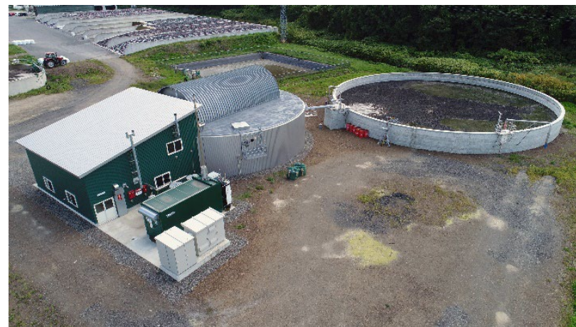
写真上 中央の円柱状の構築物が発酵槽。 その上部のガスホルダーがある。
