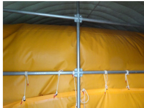
ガスホルダー。(ガスバッグ) 200 m 3 。
