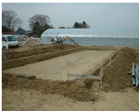
写真 1 堆肥盤堀上げ完了
