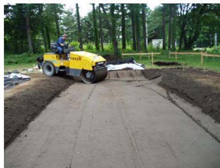
写真 6 ローラーで混合土を固めます
