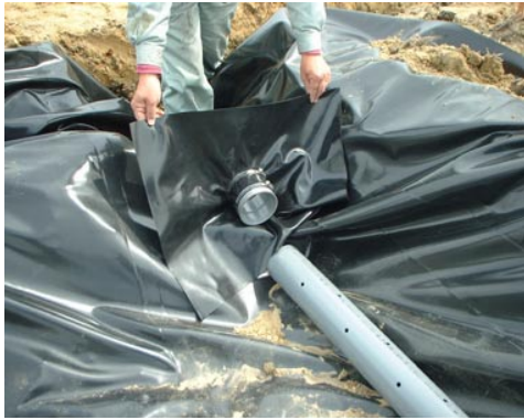
写真 3 暗きょ管及び接続管
