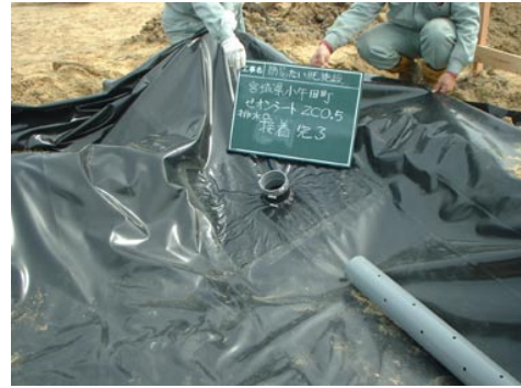
写真 4 ゼオンシートと接続管の接着完了
