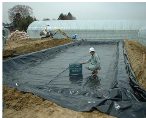
写真 2 ゼオンシート敷設完了
