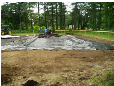
写真 5 サンデリクローズを敷き 混合土を載せます
