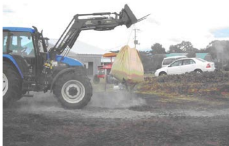
写真 1 サンデリベース材（固化材）を撒ぎます
