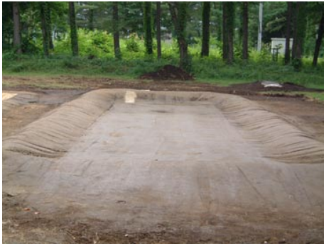
写真7 土壌固化式堆肥盤完成
