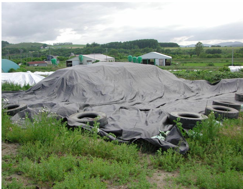
①シート利用ふん尿処理施設の全景（上部被覆シート：ラミナブラック）
