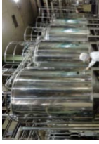
生クリーム貯蔵施設
