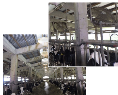
牛舎内（送風機による暑熱対策）
