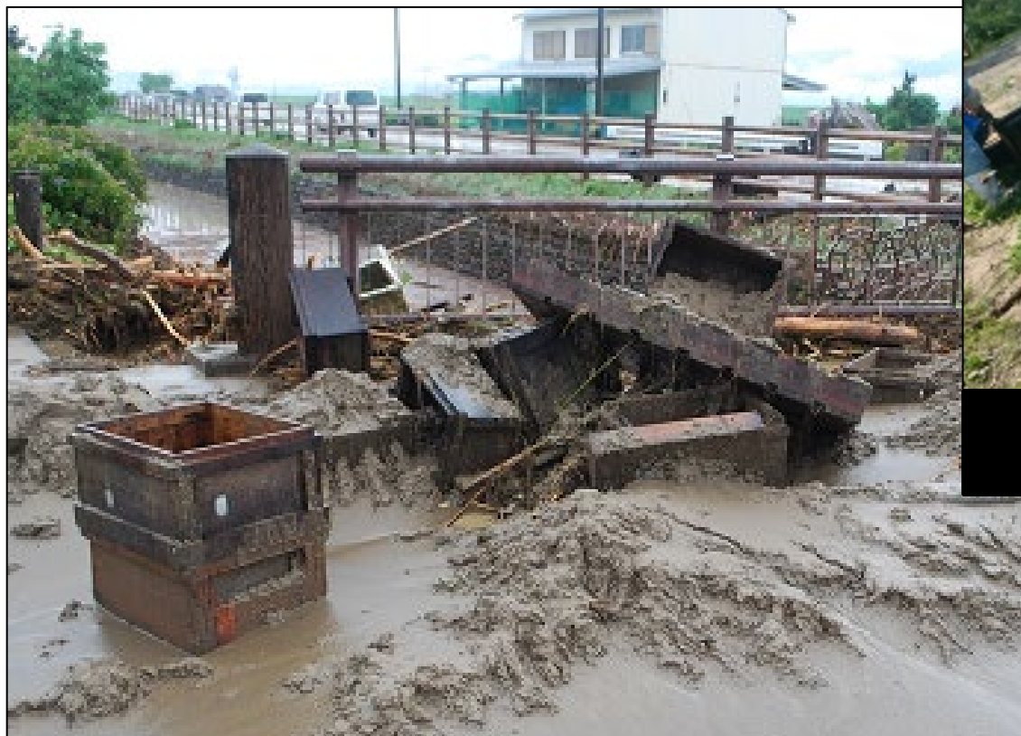
台風の大雨により流された巣箱
