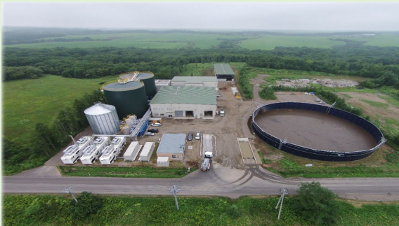
メタン発酵バイオマス発電
