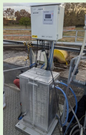
BODバイオセンサー によるばっ気量調整
