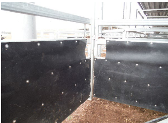
事例1：損傷等のリスクを減らすため、家畜が接する部分にシートを設置
