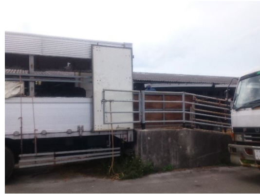
事例 2：荷台の高さに合わせた落下防止柵付き傾斜路
