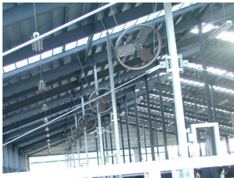
天井からの採光や 換気扇の設置
