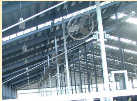
天井からの採光や 換気扇の設置
