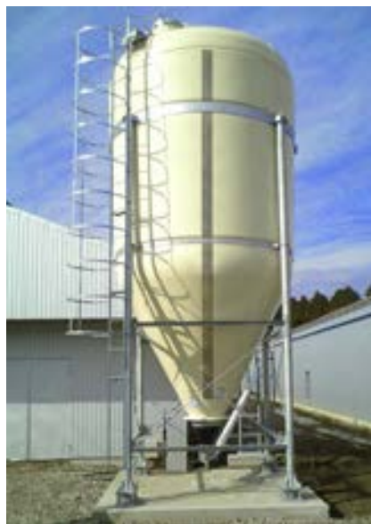
落下防止安全かご付きタンク
