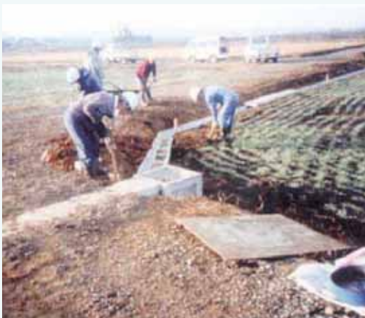
（排水路の設置作業）
