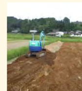
土層改良（客土）
