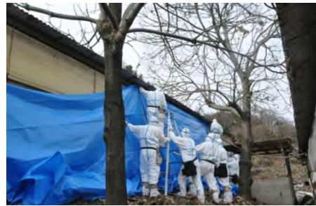
畜舎へのブルーシート設置
