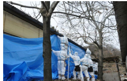
畜舎へのブルーシート設置
