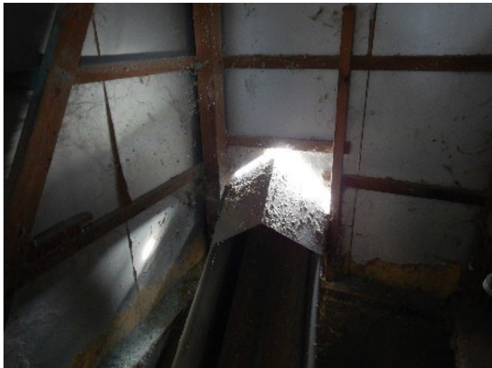
集糞ベルトの隙間
