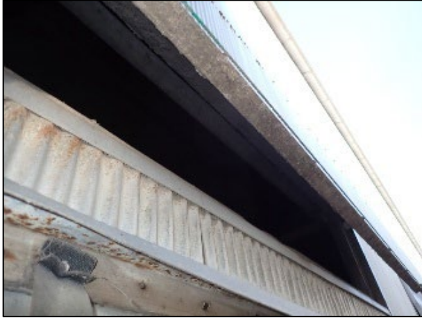
入気口の隙間
