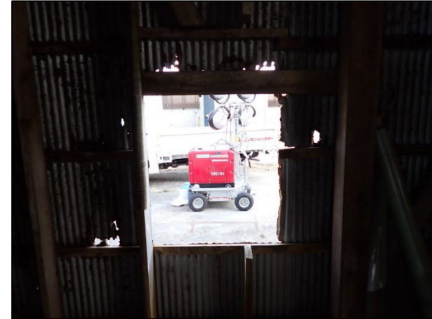
堆肥舎壁面の破損
