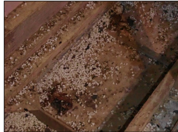
断熱材くずとネズミ糞
