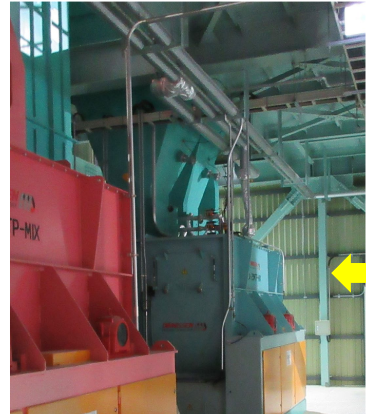
事例2 製造施設の内部(壁による分離)
