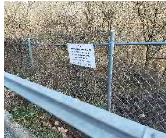
道路沿いのフェンス
