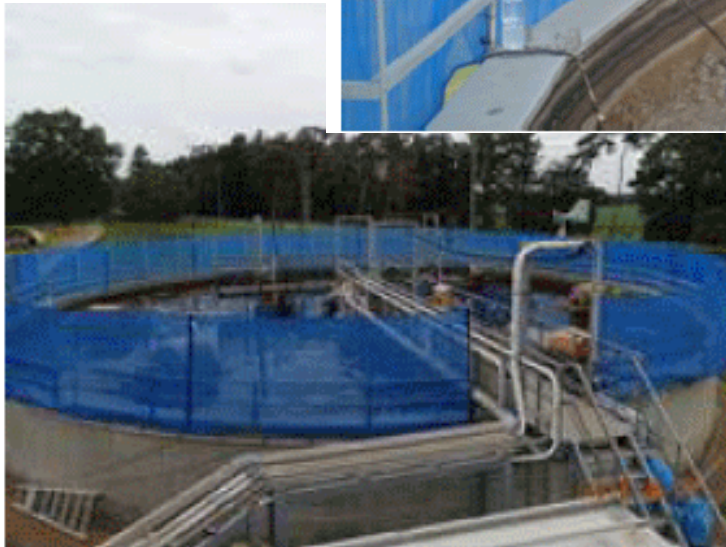
曝気槽周辺へのネットの敷設例
