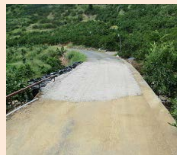
仮復旧後(平成30年8月25日時点)
