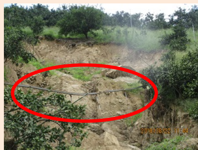
モノレール破損(愛媛県)
