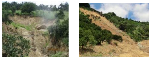
平成30年7月豪雨による 園地の崩落被害
