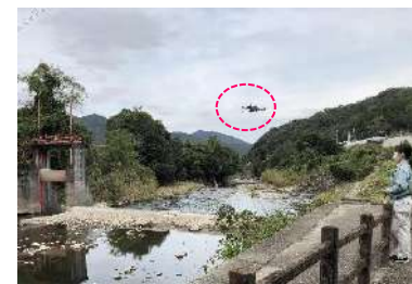
UAV（ドローン）による頭首工の 点検
