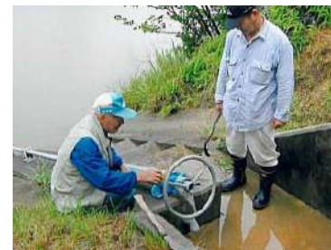
ため池取水口の保守管理
