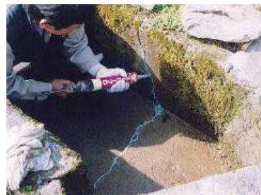
水路破損部分の補修
