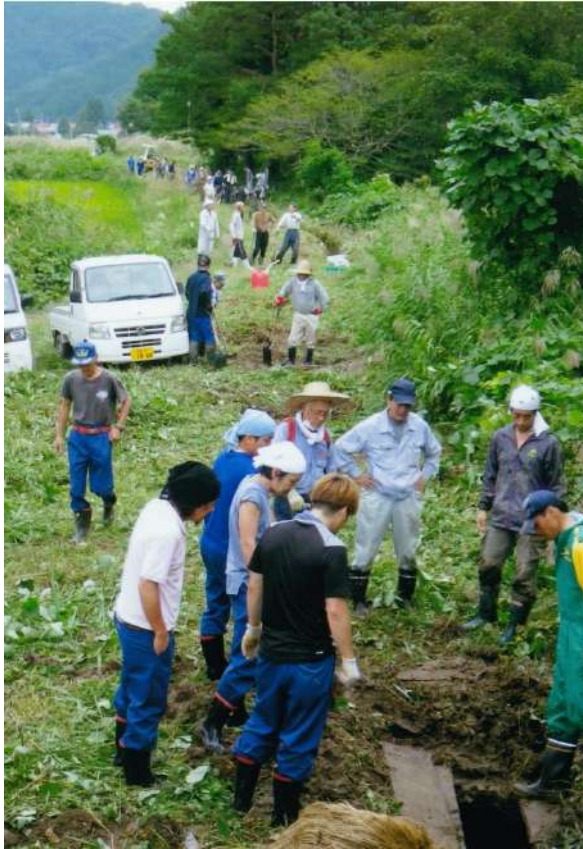
用水路暗渠部分の土砂撤去（左） と 重機による用水路土砂撤去（右）
