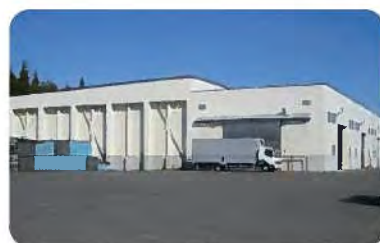
⑨ 長いも集出荷貯蔵施設
