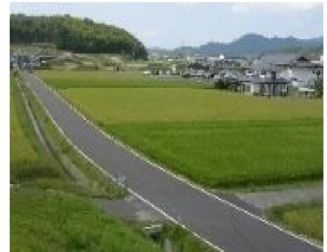
ほ場整備後の農地
