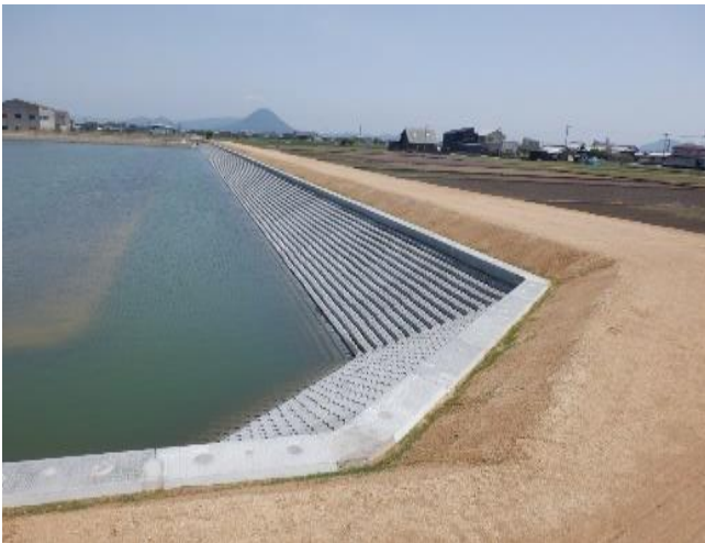
ため池の改修
