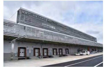
輸出手続をワンストップで完結できる 成田市公設地方卸売市場
